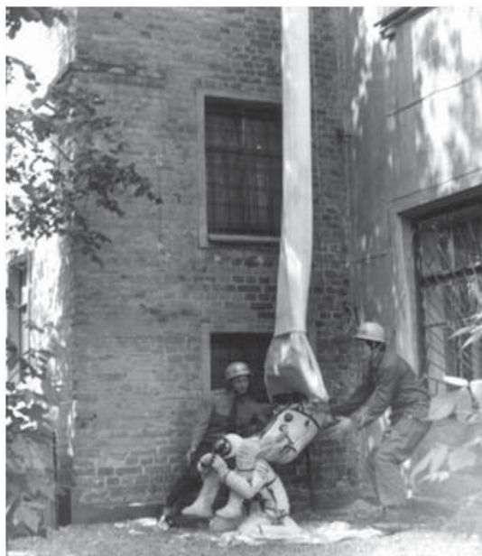
Рис. 4. Отработка вариантов спасения экипажа с ракетного стартового комплекса, ВНИИПО, 1985 г. (Ф.Л. Ибатулин, А.Н. Макаркин)
