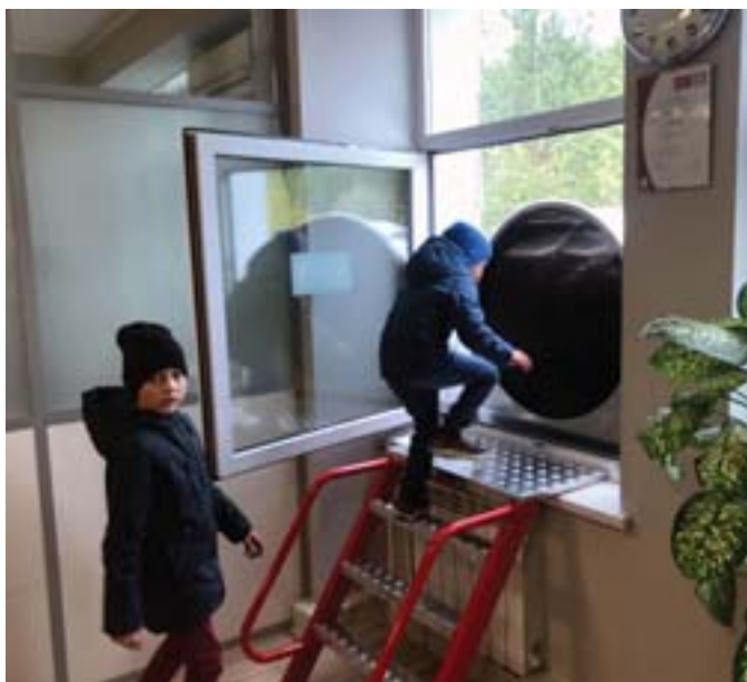
Рис. 10. Тоннель спасательный пожарный с входом через окно
